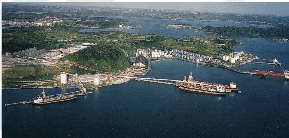
Figura 8 - Vista aérea do Porto de Aratu
